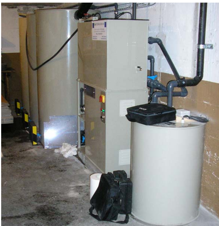
SX9 avec dessableur, déshuileur, cuve de stockage et cuve de sortie avec pompe de relevage
