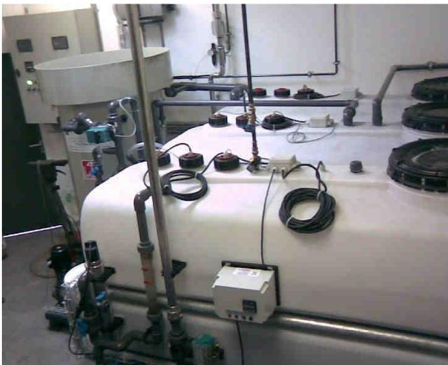
**FBR Anlage für 2 m<sup>3</sup> pro Tag parallel zu einer KLA « A » zur Aufbereitung von bis 5 m<sup>3</sup> pro Tag. Die KLA Anlage ist mit einem automatischen Rückspülfilter, einer Neutralisation in eine Richtung und einer chemischen Oxydation ausgerüstet.**
