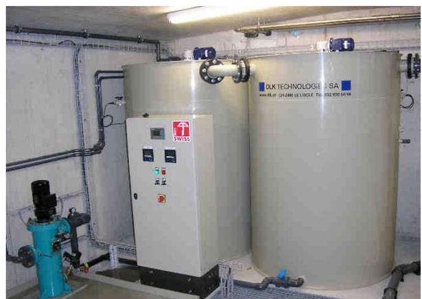
**KLA « A » Anlage mit automatisch rückspülendem Filter, pH Einstellung in beiden Richtungen und chemischer Oxydation.**
