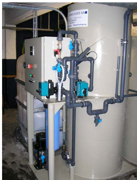
Bioréacteur avec cuve extérieur, correction automatique du pH dans 1 sens, séparateur d'hydrocarbures extérieur, débit jusqu' à 2 m 3 par jour
