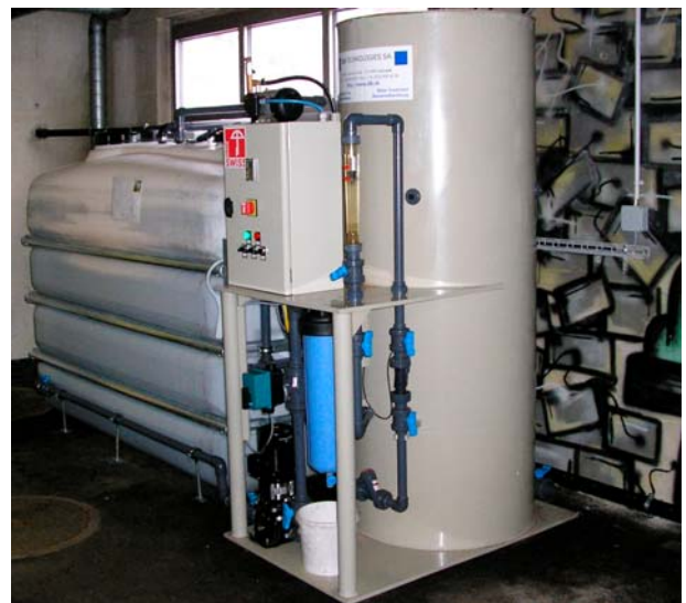
Bioréacteur FBR EasySwiss avec cuve hors sol, débit jusqu'à 2 m 3 par jour
