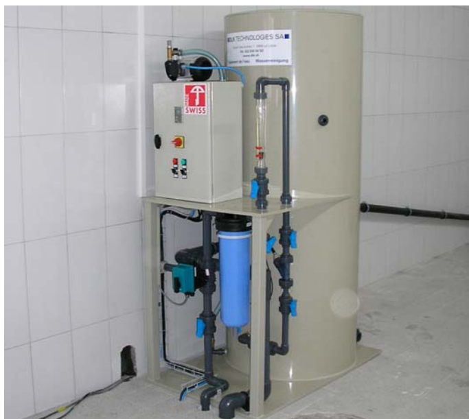
Bioréacteur avec cuve enterrée
