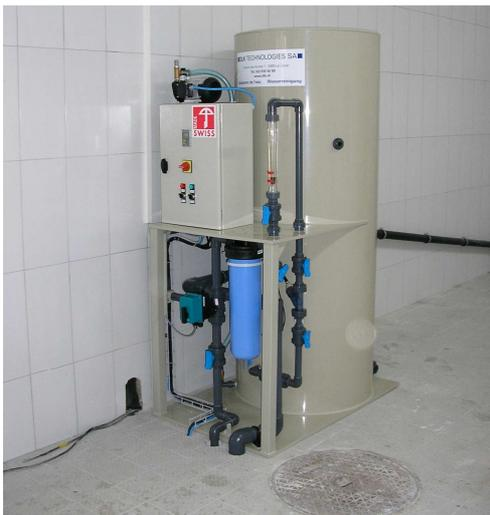
**Bio-Reaktor mit unterirdischem Arbeitsbehälter**
