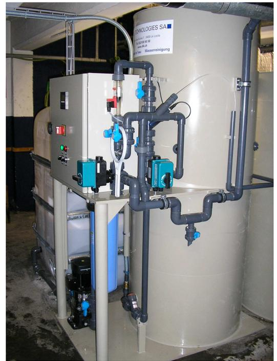
**Bio-Reaktor mit Arbeitsbehälter mit oberirdischem Mineralölabscheider und Option pH-Wert-Neutralisation**
